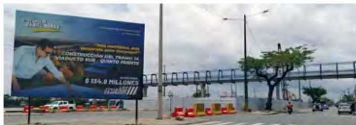
Obra en construcción para el Quinto Puente.
