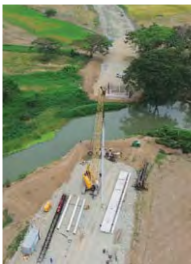
Paso lateral Babahoyo – Jujan (foto oficial).
