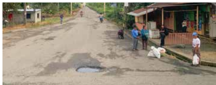
Huecos por doquier en la vía Caluma – Montalvo.
