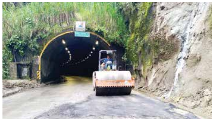
Túnel Cadenillas cortesía MIT.
