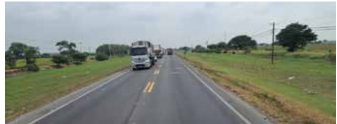
Vía al PAN es estrecha y solo de dos carriles.
