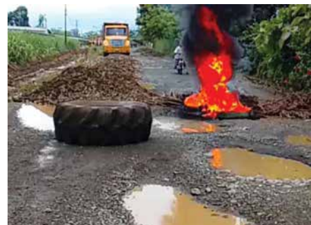
Los azotes del invierno destruyeron vías
