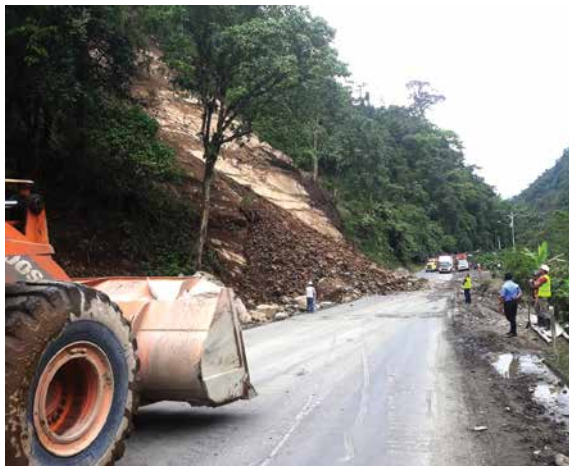
Derrumbe km 48 en vía a Santo Domingo.
