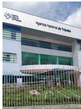
Edificio matriz de la ANT.
