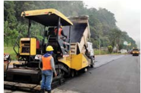
Mantenimiento en Alóag-Santo Domingo.
