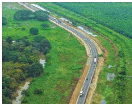
Vista aérea de la E25 en Los Ríos.
