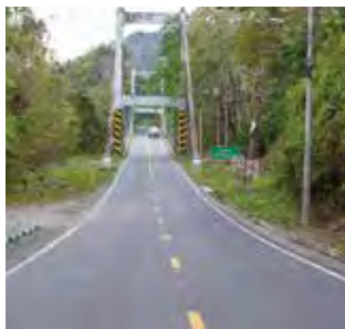
Vía E15 rehabilitada luce atractiva.
