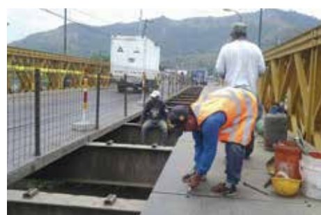
Arreglos en las vías estatales.
