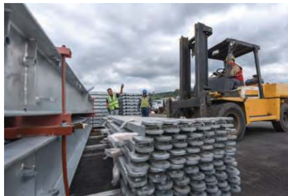
Material de acero para los puentes Bailey.
