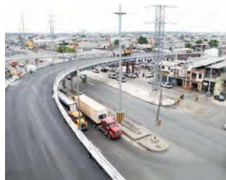
Panorámica del viaducto que conecta Trini-puerto y Perimetral.
