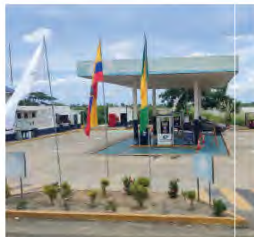
Estación de Petroecuador
