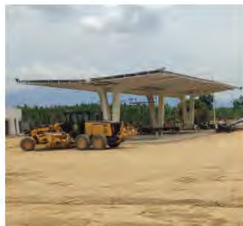
Construyen nueva estación en Santa Rosa.
