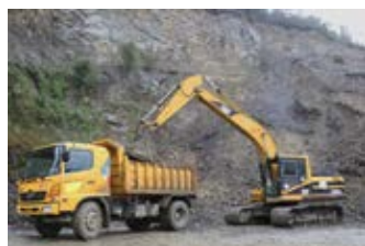
Maquinaria realizando trabajos.
