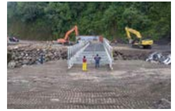
Puente Bailey sobre río Piedra Fina.
