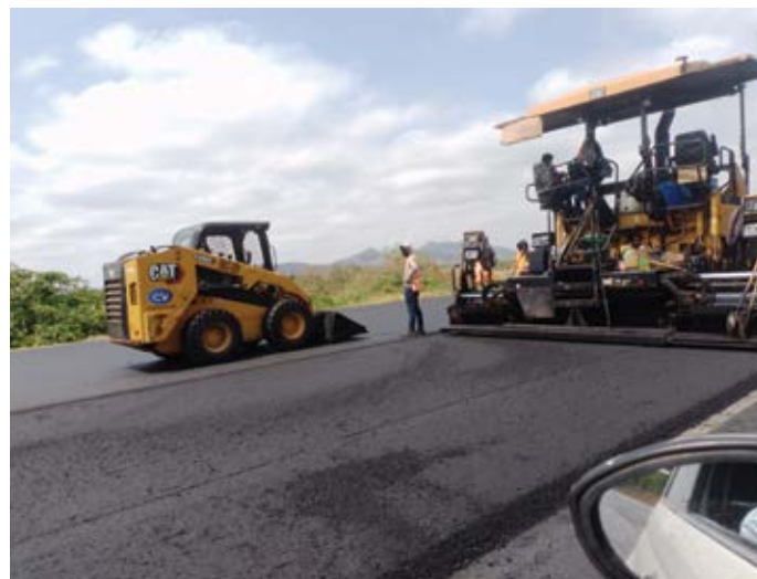
Reparando la vía a la altura de Buenos Aires.
