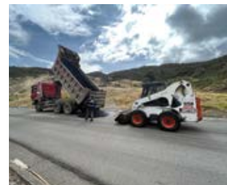
Mantenimiento de la vía.
