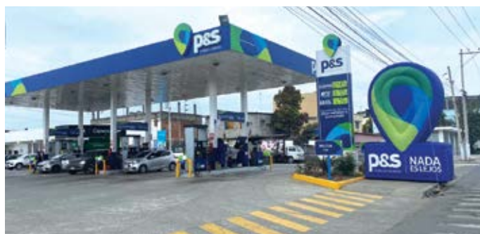
Estación de servicios.
