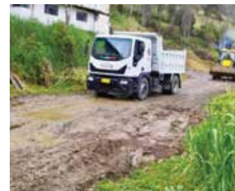
Vías rurales de Cañar en mal estado
