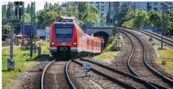
Metro subterráneo y exterior.
