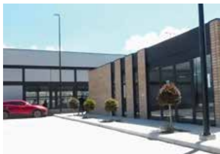
Instalaciones del CRTV de Cañar
