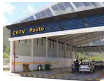
Instalaciones del CRTV
