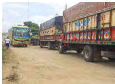
El pésimo estado de la calle de acceso a Salitre genera largas filas y pérdida de tiempo a los transportistas.
