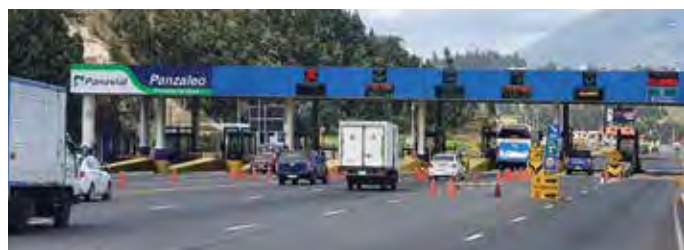
El mantenimiento de las vías, un beneficio crucial para el transporte.
