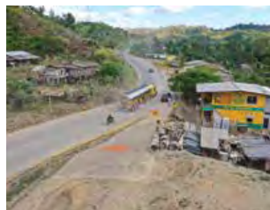
Vista del actual estado de la vía Esmeraldas-Quinindé.
