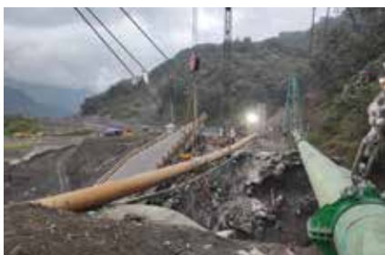
Trabajos sobre el río Marker.
