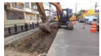
Trabajos de refuerzo sobre calle Bolivia.
