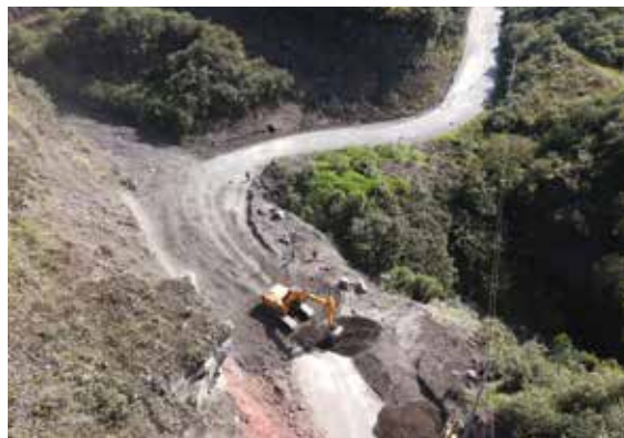
Labores de ensanchamiento en un tramo de la vía.
