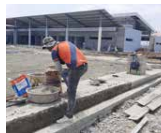
Al momento se continúan realizando trabajos de mampostería en la obra.
