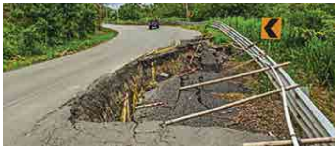
Vía en estado crítico.
