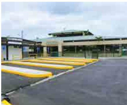
La nueva estructura inaugurada.
