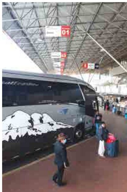
Señalética de los andenes reestructuradas.
